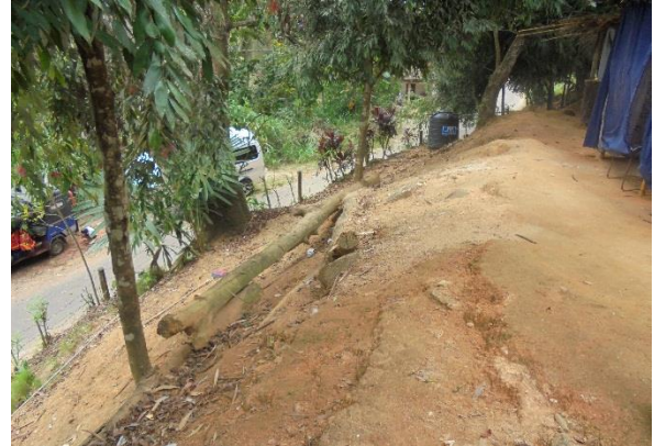
படம் d: வெட்டப்பட்ட சாய்வுத் தோல்வி சுகாதார வசதிகளுக்காக மூடுகிறது
